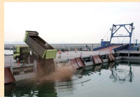
浮棧橋から廃棄物が投入されました。
