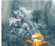
廃プラスチックピット
