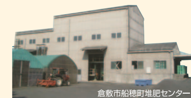
倉敷市船穂町堆肥センター
