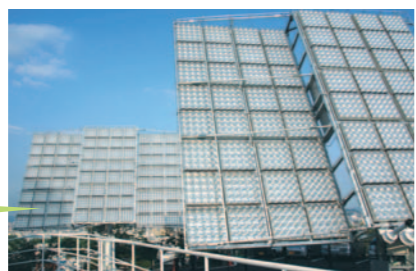
発電効率の高い太陽追尾式のソーラーパネル。1基の発電量は15kw
