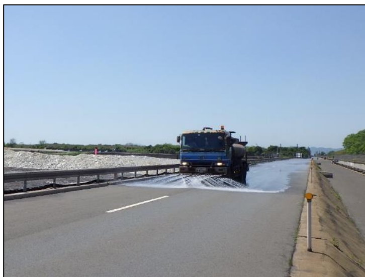
写真 7-2 散水の状況 (令和 5 年 2 月 22 日撮影)
