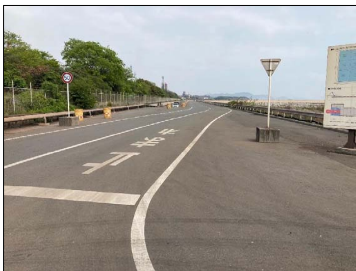
写真 7-1 アスファルト舗装の状況 (令和 5 年 3 月 31 日撮影)
