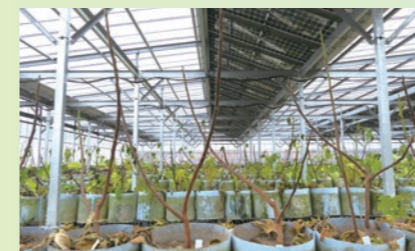
オープン型ではなく、閉鎖型のソーラーシェアリング施設のため気候変動の影響を受けにくい。
