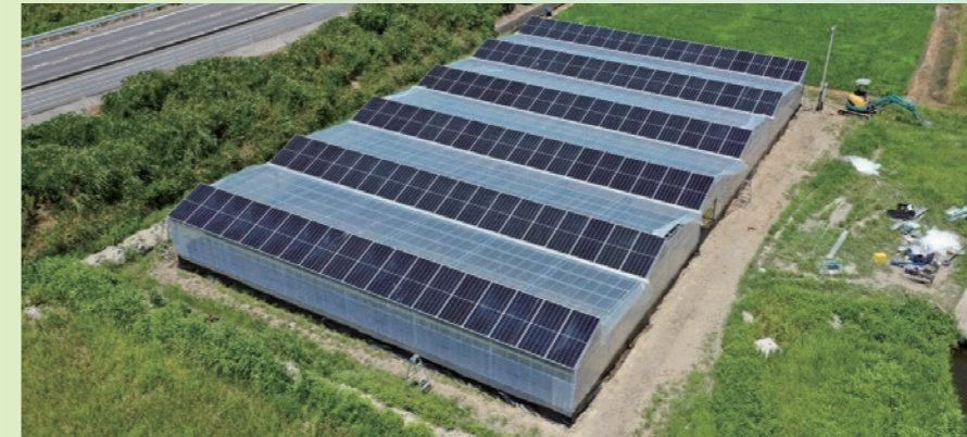
栽培作物に合わせて太陽光パネルの配置間隔を調整することで、遮光率のコントロールが可能。
