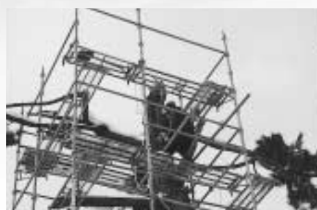
高所(約20m)に足場を組み、腐朽部の高所作業。
