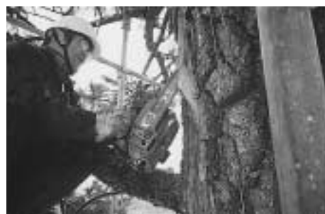
チェーンソーにて腐朽部の除去。この後、殺菌剤を塗り、水が入らないようにウレタンを詰め、表面を固めてペイントで仕上げます。
