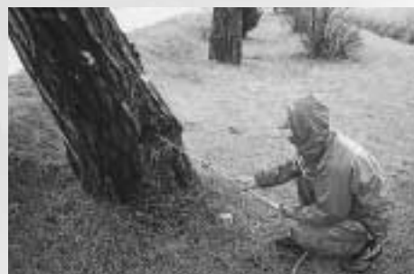
腐朽部を高圧ポンプにより除去。水の力で腐った部分を取り除きます。
