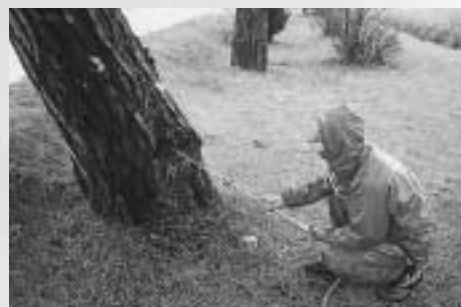
腐朽部を高圧ポンプにより除去。水の力で腐った部分を取り除きます。
