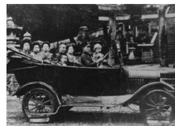
乗合自動車、次々と開業 岡山県に乗合自動車が初めて登場したのは1912年(大正元年)。本格的な営業は1917年(大正6年)片上-岡山間が最初。その後2.3年の間に津山、宇野、新見などに相次いで開設された。写真は片上宇佐八幡宮の前。1918年(大正7年)頃
