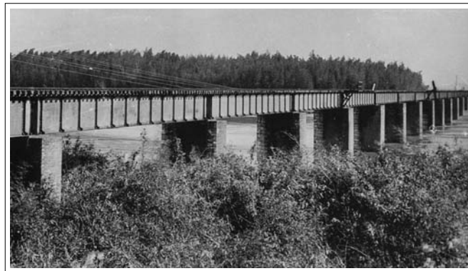
1907年 明治40年 高梁川大改修工 下流の酒津(現・倉敷市)で東西二流に分かれていた西川・東川のうち、再三の大洪水を防止するために東川を廃川にする改修工事が18年の歳月をかけて行われた。写真は姿を消した東川。山陽本線の鉄橋が架かる。現在の倉敷市営球場の北付近。
