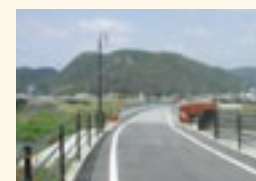
金剛川橋付近
