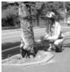
ブラタナスの危険木の点検。幹に穴を開けて中心部を抜き取るボーリング調査を行っています。根元が腐っていたので、この木は伐採されました。
