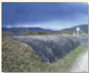
分流部にある「一の荒手」。旭川の水かさか一定量を超えると、ここから水が流れ込み、下流の「二の荒手」「三の荒手（現在は無い）」で流れが緩和するようになっています。「二の荒手」の幅が百間（約181.8m）あったことから百間川と呼ばれるようになったそうです。
