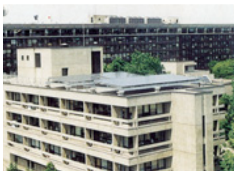
岡山県庁屋上に設置された太陽光発電システム
