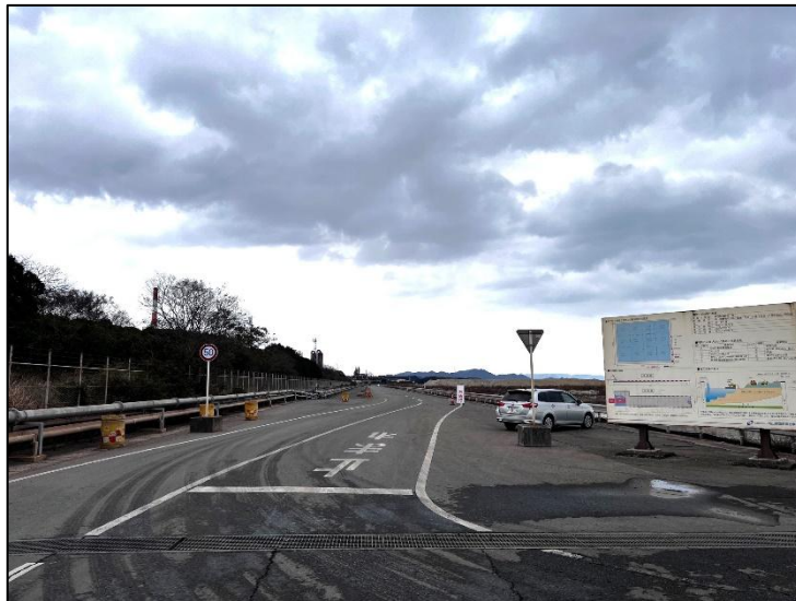
写真 7-1 アスファルト舗装の状況 (令和 7 年 1 月 17 日撮影)
