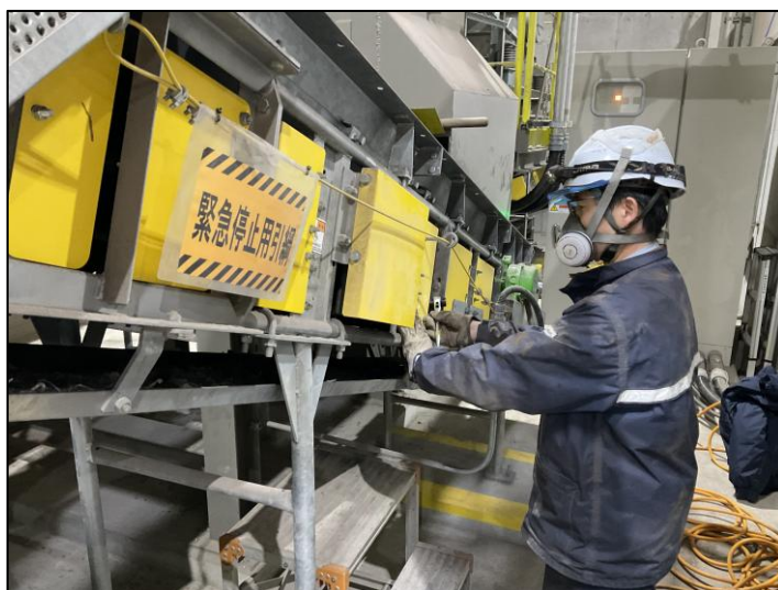
写真 7-7 機器点検の状況 (令和 7 年 1 月 24 日撮影)
