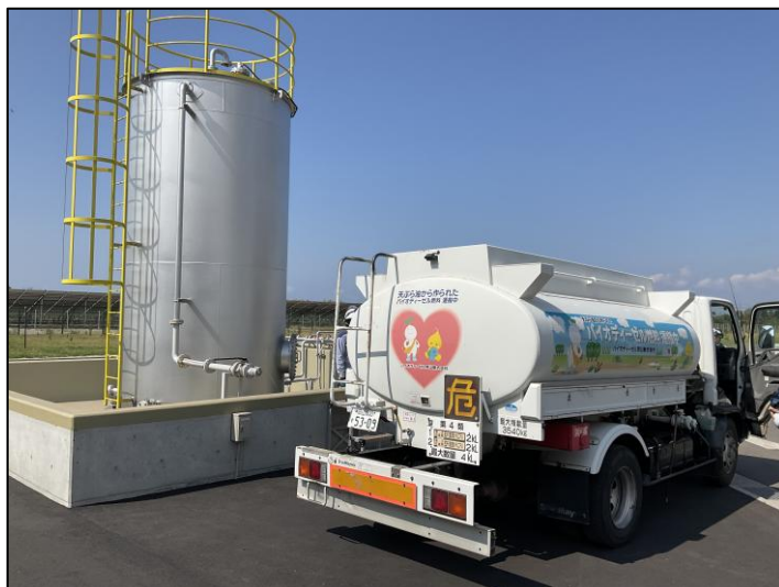
写真 7-6 BDF 納入時の状況 (令和 6 年 9 月 5 日撮影)
